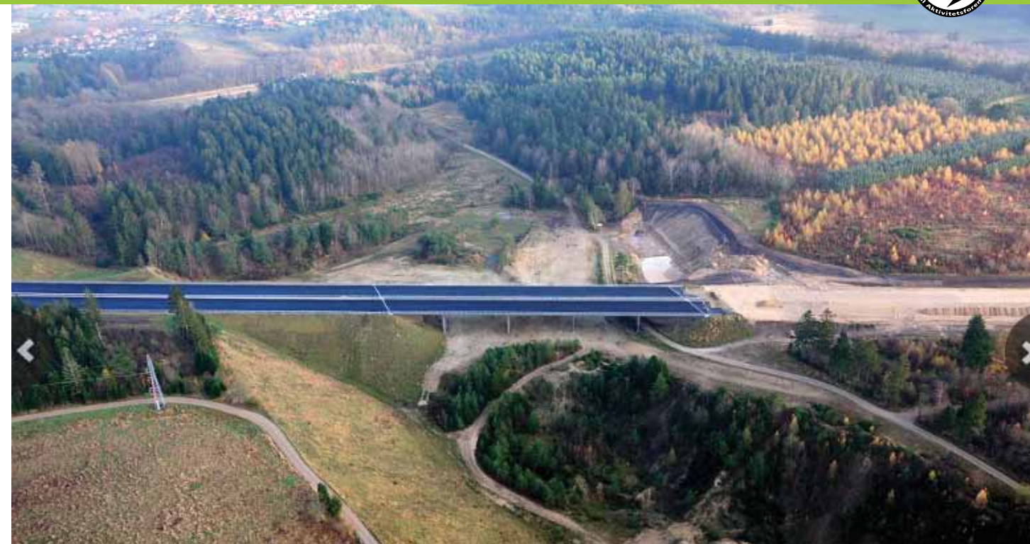
Ved Lokalrådets kommende møde, vil man drøfte videreførelsen af Vestre Højmarksvej helt ud til Funder. Billedet her viser den 150 meter lange landsskabsbro i den tidligere grusgrav ved Hvinningdal.
